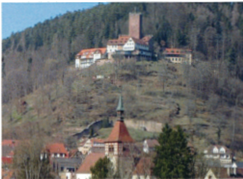
Die ältesten Bauwerke in der Stadt Bad Liebenzell, Burg und evangelische Kirche St. Blasius
